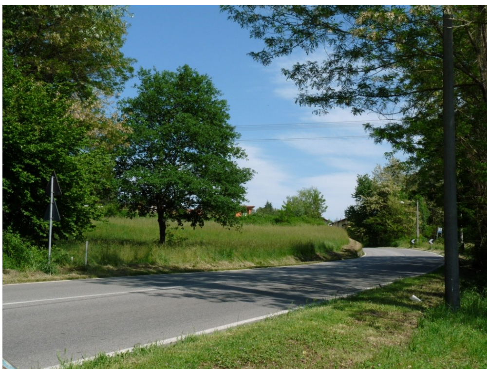
Il sito di intervento C10d sulla SP 36
