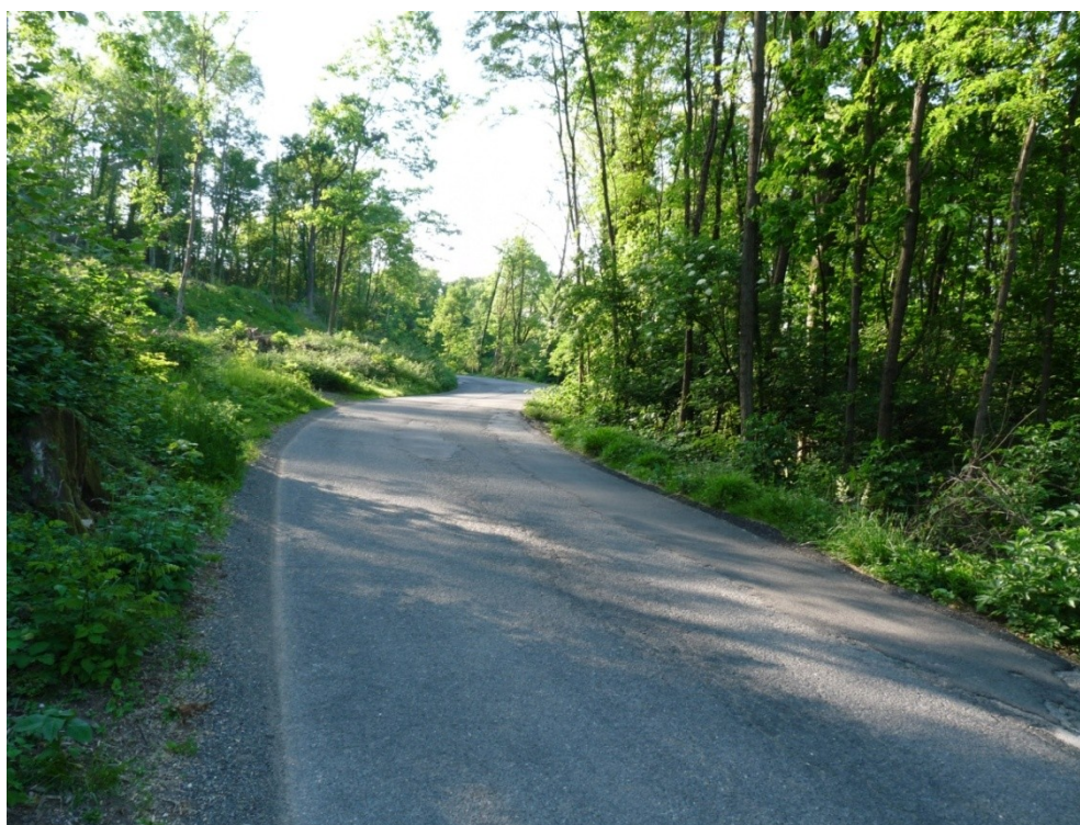
Il tratto percorso durante i sopralluoghi nel sito di intervento C1d
