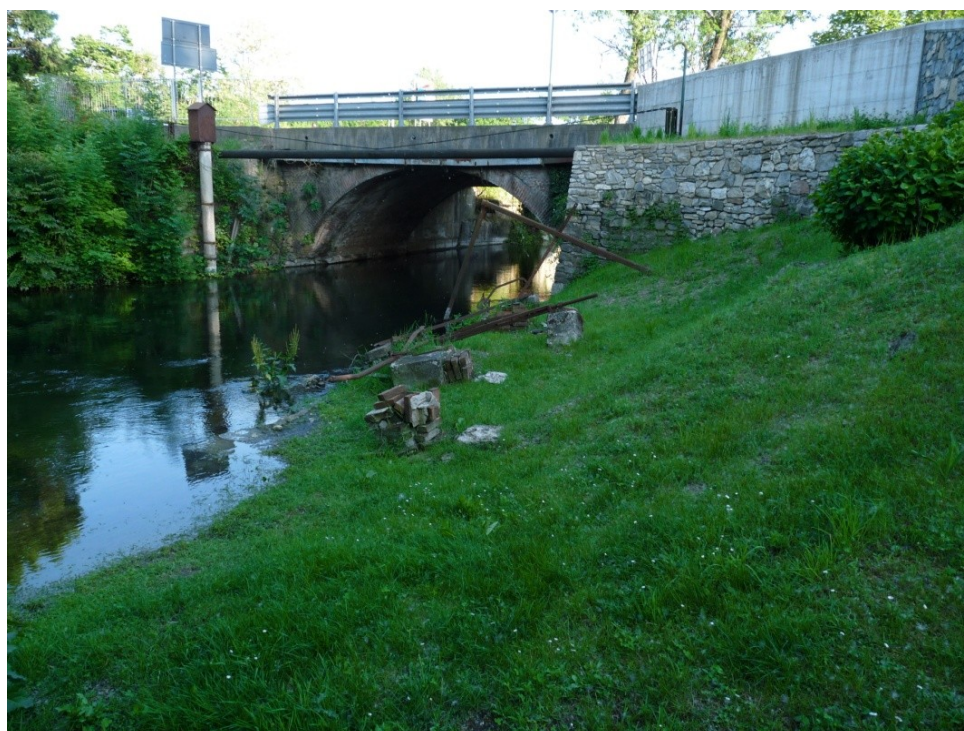
Il passaggio del torrente Bardello sotto viale Ticino nel sito C12b
