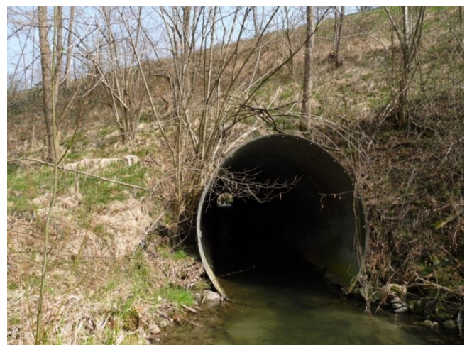
Passaggio del torrente Acqua Nera (a destra) sotto la SS 629 (a sinistra) privo di strutture idonee al passaggio di piccola e media fauna, marzo 2014
