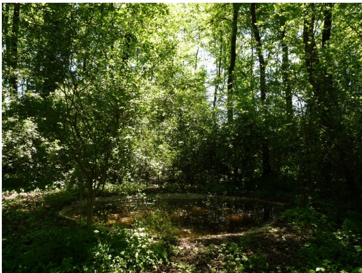
La pozza di nuova realizzazione presso Cascina Spazzacamino a Daverio. Anche in questo caso si può notare l'eccessiva presenza di ghiaia lungo i margini della pozza
