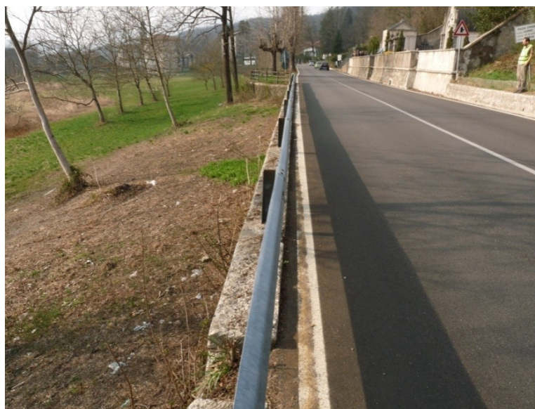
Il tratto monitorato della SP 62 in entrata verso l'abitato di Brinzio
