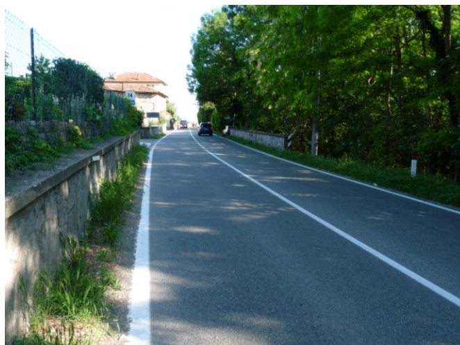
A sinistra il corso d'acqua sotto la SS 394. A destra, il sito di intervento C10c, maggio 2014
